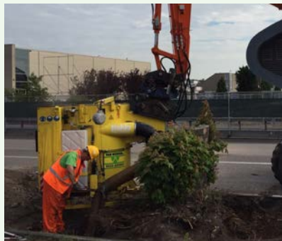
Omschrijving Grondzuiger Bijzonderheden Compact Kranen ✓ Dieptebereik 2,00 m Slangdiameter 250 mm Containervolume 0,25 m 3 Bestelnummers 12576
